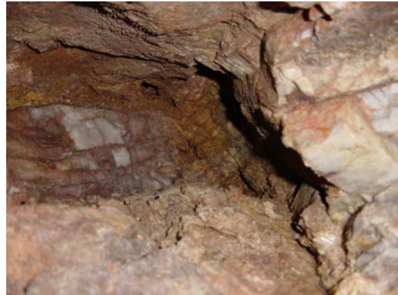
Abb.24: Ausgebrochene, mit Quarz „ausgekleidete“ Stelle
