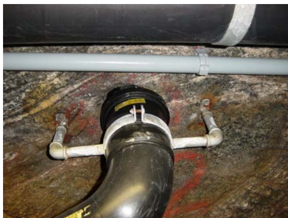
Abb.19: Verankerung Hausanschlüsse
