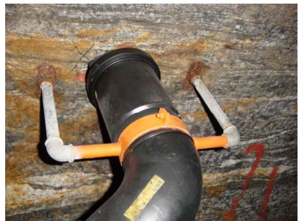
Abb.20: Verankerung Hausanschlüsse mit Schutzanstrich
