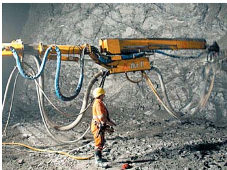
Abb.12: Bohrung von Sprenglöchern
